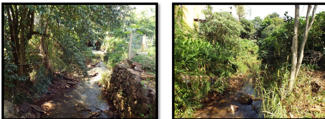
Figura 89 e 90 – Área sujeita a alagamento.
