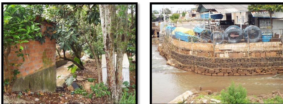
Figura 46 e 47 – Edificação sobre o curso d'água (esq.) e ponto de confluência dos rios (dir.).
