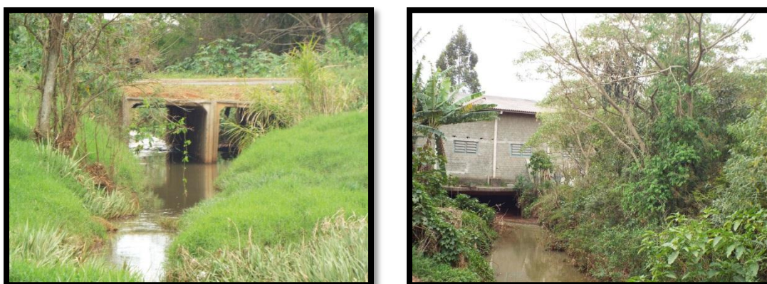
Figura 32 e 33 – Trecho com gramíneas e vegetação arbórea nas margens (esq.) e construção sobre o curso d'água (dir.).
