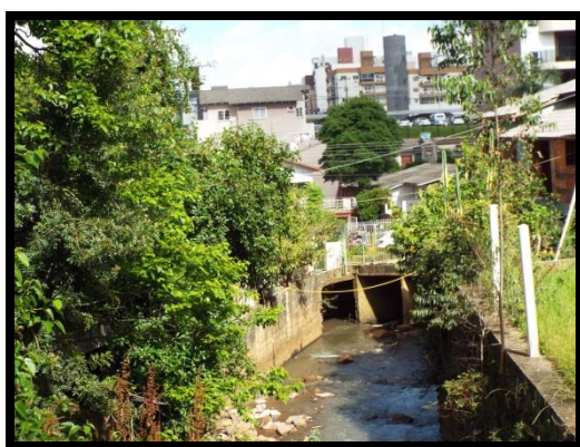
Figura 72 – Construções às margens do curso d'água.
