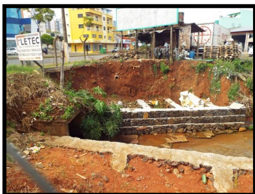
Figura 63 e 64 – Trecho sujeito a alagamento e risco geotécnico (esq.) e edificação sobre o curso d'água (dir.).
