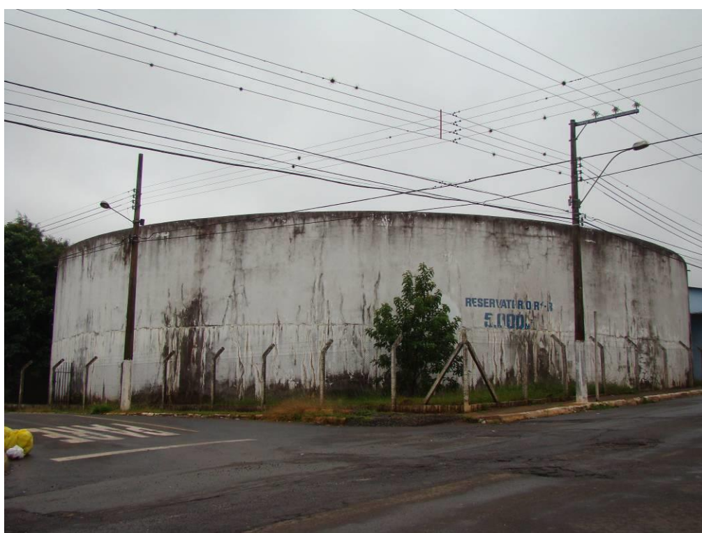
Figura 38: Reservatório principal – R1 com 5.000m 3
