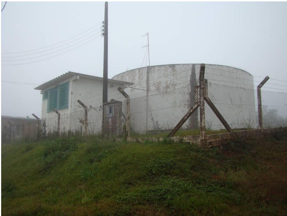
Figura 43: Reservatório no bairro Santa Maria
