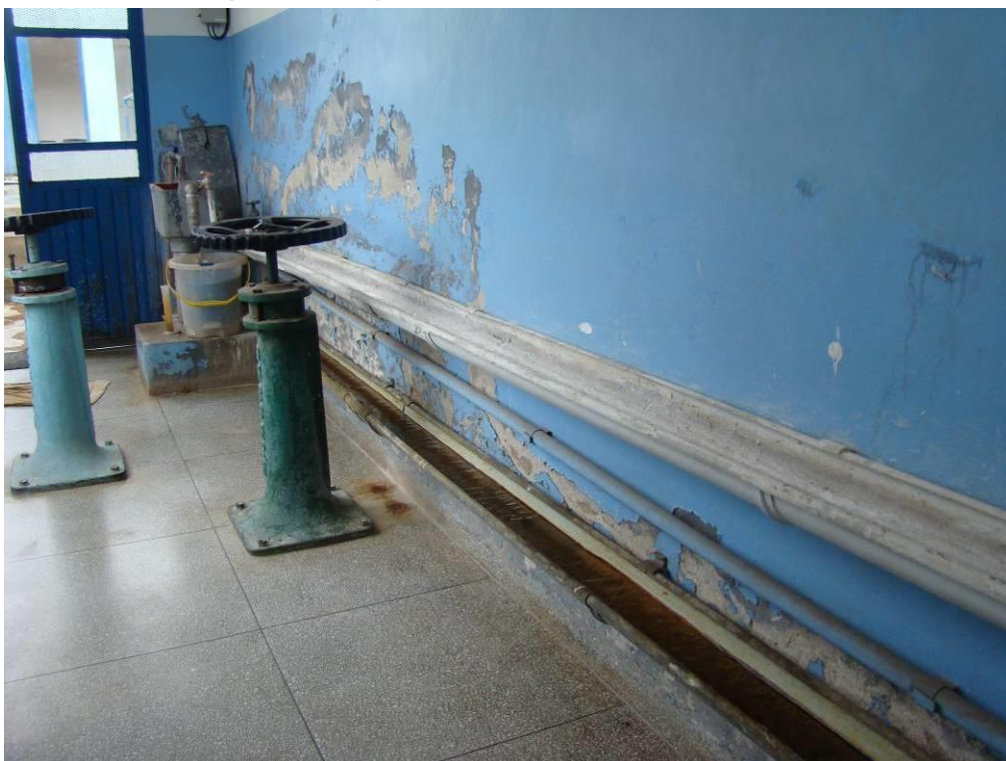
Figura 33: Calha de aplicação dos produtos químicos
