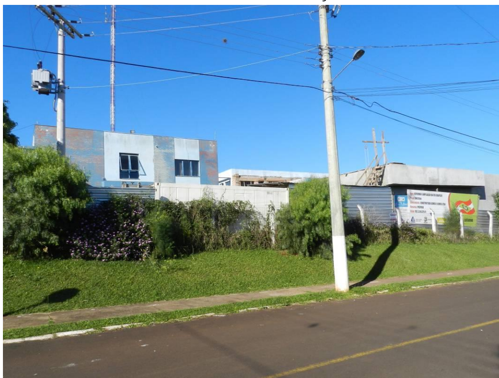
Figura 2: Prédio da ETA antiga com a ampliação ao lado
