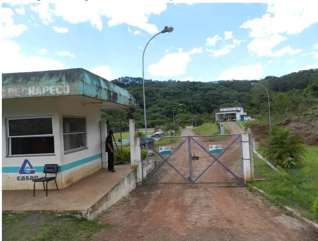
Figura 55: Entrada da ETE de Chapecó
