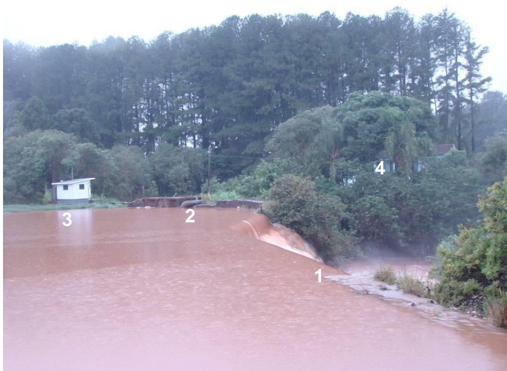
Figura 22: Sistema de captação/adição de água bruta: 1 barragem, 2 captação, 3 casa de máquinas, 4 estação elevatória de água bruta. (Altitude: 609m)
