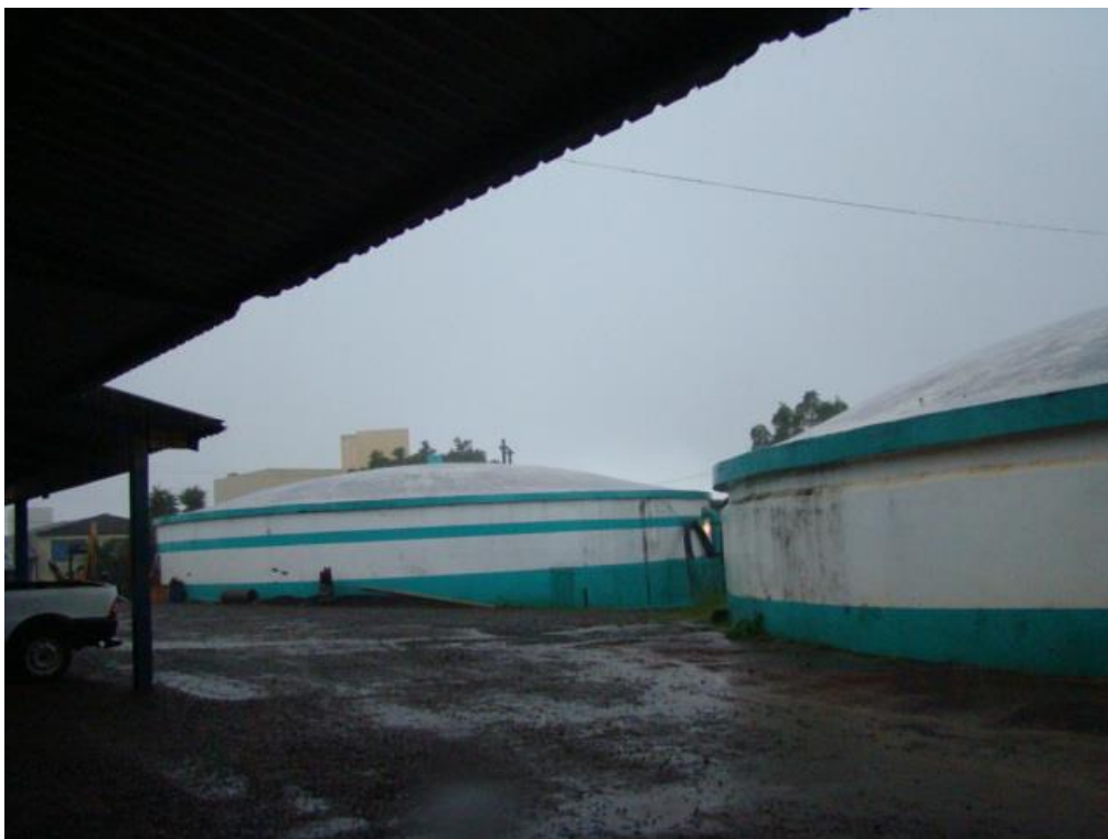
Figura 39: Reservatórios R1 A e B pertencentes ao conjunto R1 situado perto da ETA no bairro São Cristóvão
