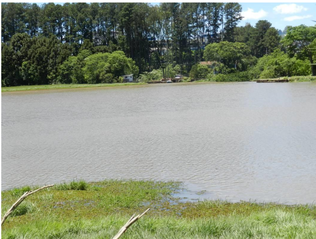
Figura 12: Barragem do Lajeado São José com presença de vegetação nas margens.
