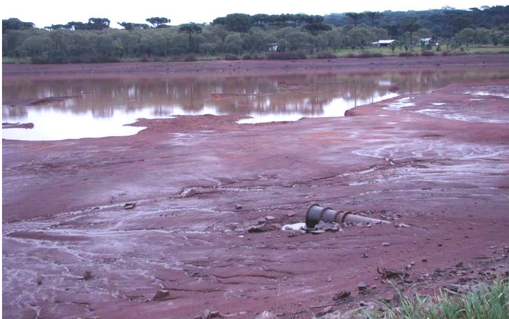
Figura 21: Ponto de captação na Barragem de Guatambú (Foto de 22/04/10 – precipitação de 95mm em 24horas)
