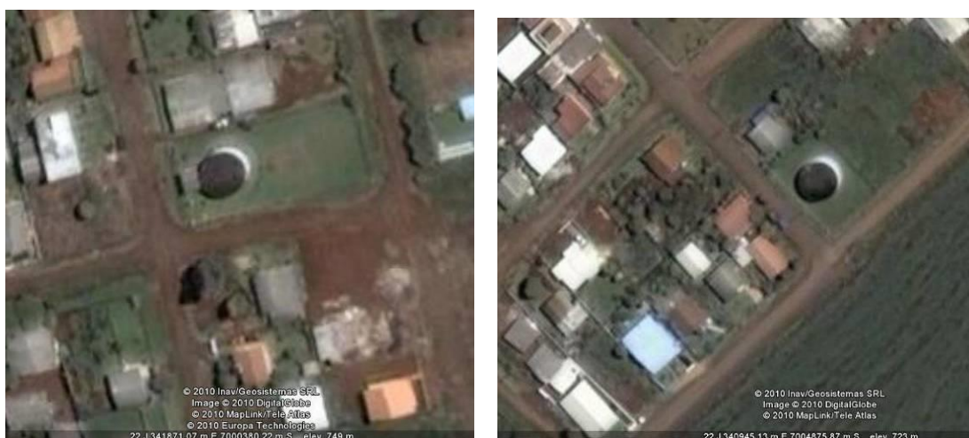
Figura 42: Reservatórios nos bairros Santa Maria e Vila Real
