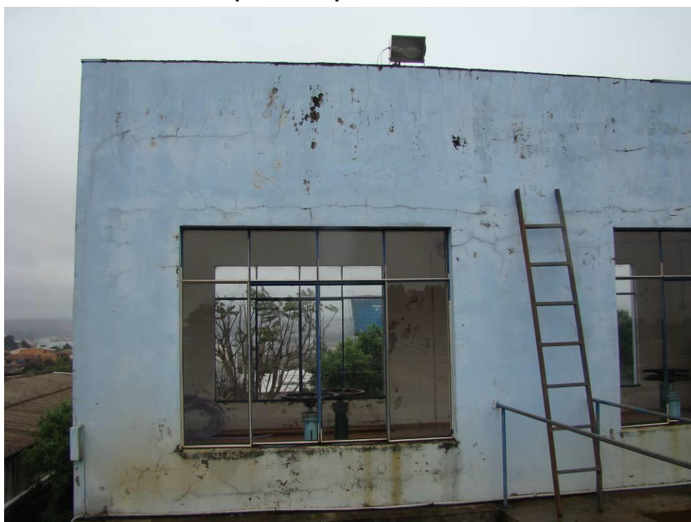
Figura 4: Detalhe da parte superior do prédio da ETA
